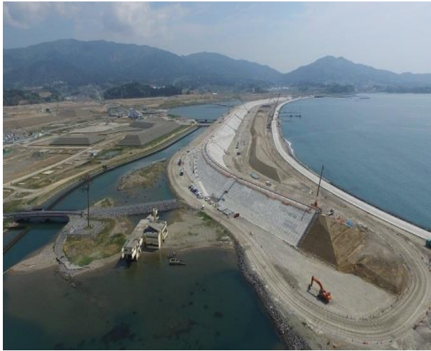
리쿠젠다카다시 다카다지구 해안재해복구공사 현황 (2016년 5월 촬영)
